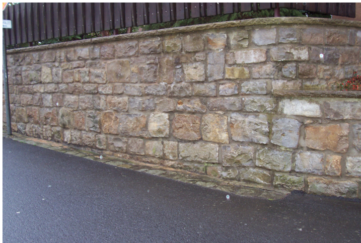
Bruchsteinmauer aus Zugsteinen aus den 70er Jahren
