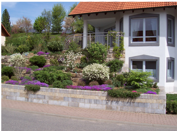
Gartenanlage mit Muschelkalk-Bruchsteinen Mauer aus gesägten Muschelkalksteinen
