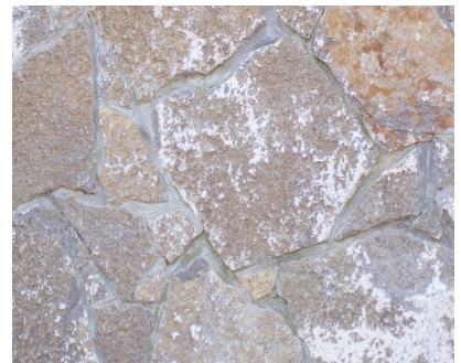
Krustenplatten im Polygonalverband als Wandverkleidung
