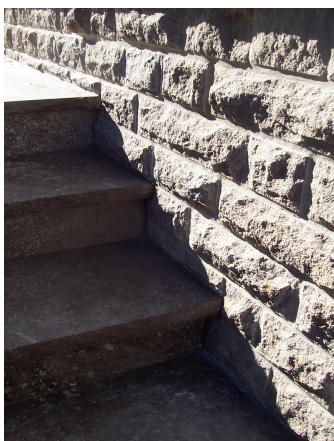
Treppenabgang mit Wandverkleidung
