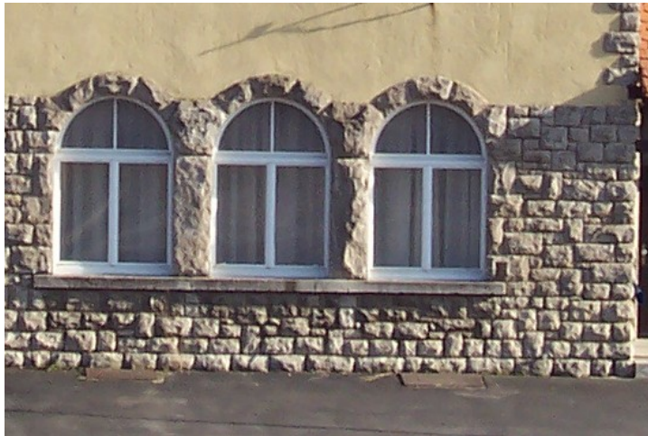
Bossensteine gerichtet, mit Einfassung Bogenfenster.
