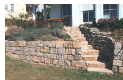
Trockenmauer mit Blochstufen-Aufgang
