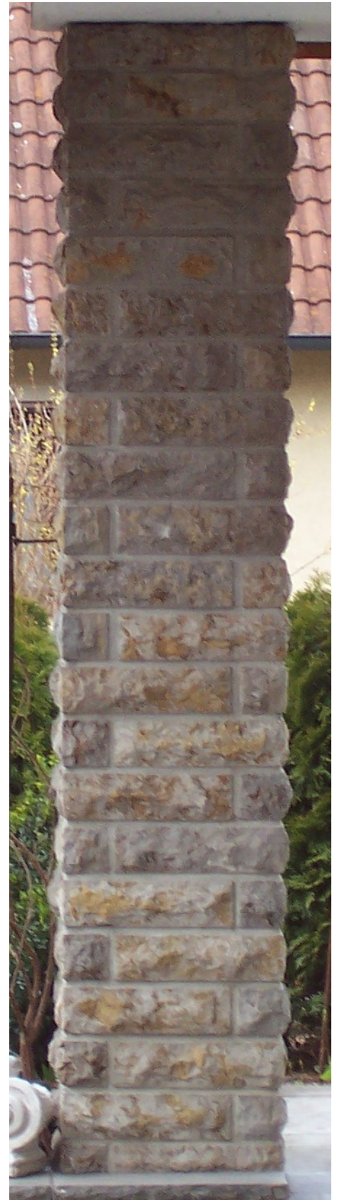
Stahlstütze mit Bossensteinen verkleidet
