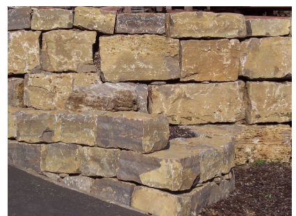
Krustenplatten im Polygonalverband als Wandverkleidung
