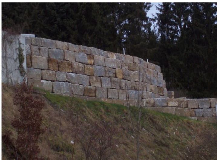
Bruchsteinmauer aus Zugsteinen aus den 70er Jahren
