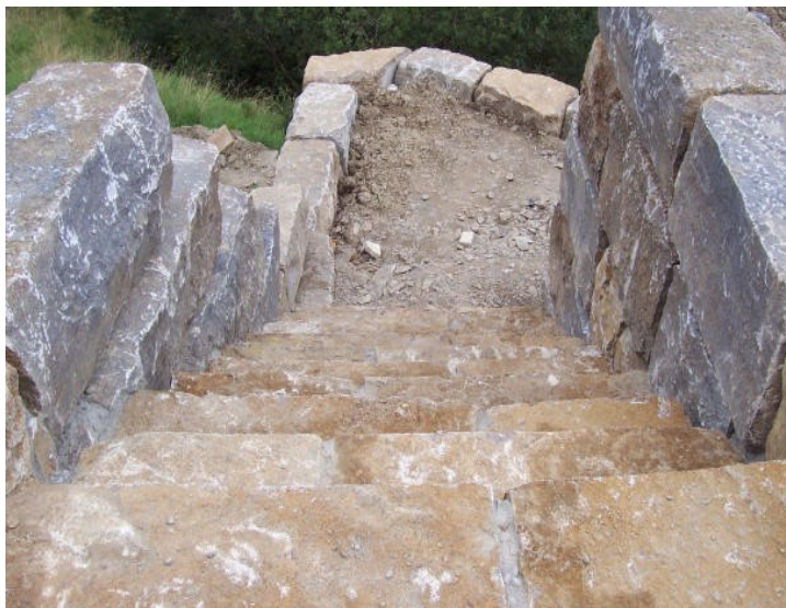
Blockstufen mit bruchrauger Oberfläche und Ansicht. Untersicht und Stoßfugen gesägt, Kanten gerichtet.
